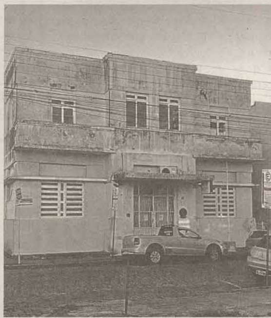
Agência dos Correios, à rua Osvaldo Cabral. Arquitetura modernista, porém de característica oficial, representativa de obras públicas, na década de 40.
